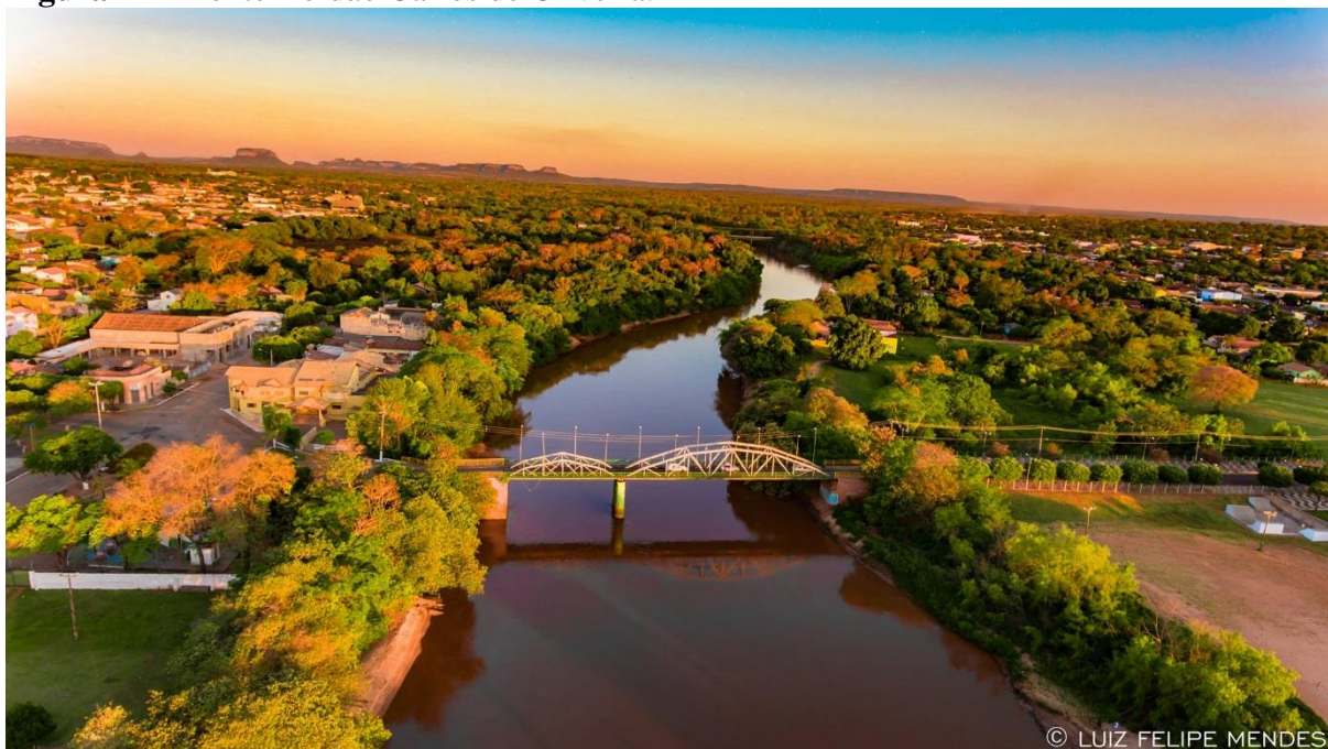
Figura 72 – Ponte Roldão Carlos de Oliveira.
