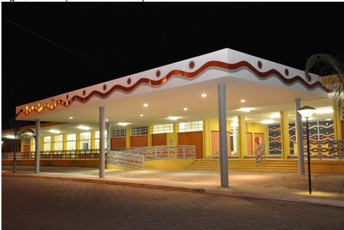
Figura 61 – Estação Ferroviária de Aquidauana.
